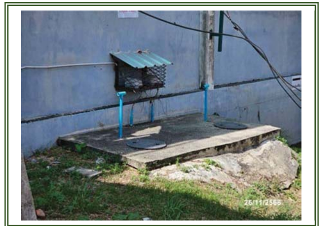
รูปที่ 3-14 ระบบบำบัดน้ำเสียสำเร็จรูปชนิดเติมอากาศ แบบ Aerobic Fixed Film
