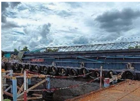
รูปที่ 3-54 ราวกันตกที่ด้านข้างท่าเทียบเรือ และ Safety Platform
